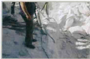
Excavación y vaciado
