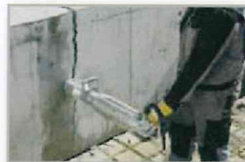
Quebrantado y demolición de hormigón
