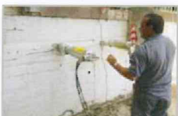
Demolición en interiores
